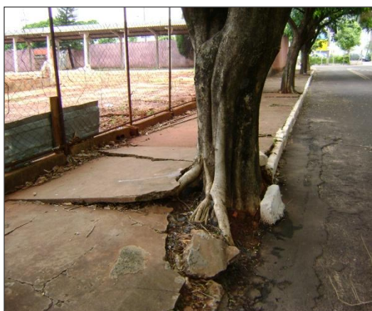
Figura 13. Espécie de Ficus e Sombreiro, respectivamente, causando danos à calçada e meio-fio. Fotos: Alessandra Ribas Buch (dez/2009).
