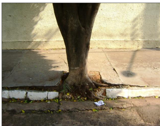
Figura 13. Espécie de Ficus e Sombreiro, respectivamente, causando danos à calçada e meio-fio. Fotos: Alessandra Ribas Buch (dez/2009).
